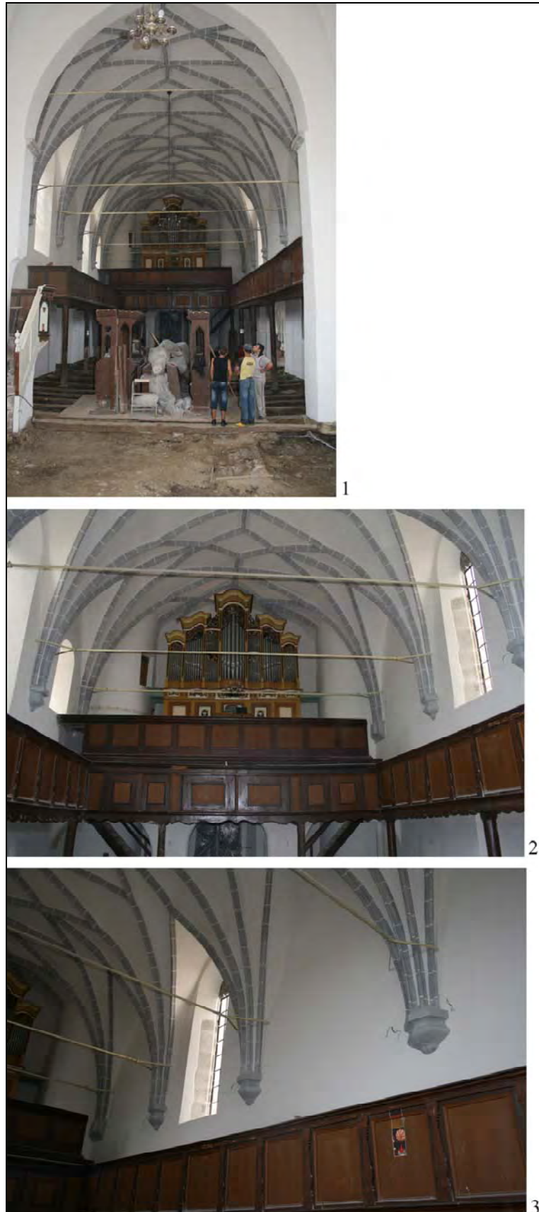
Pl. 4. 1. Interiorul bisericii, vedere generală spre vest, cu bolțile navei. 2. Detaliu cu partea vestică a navei, tribuna orgii și empoarele din lemn. 3. Detaliu cu partea inferioară a bolților navei.
