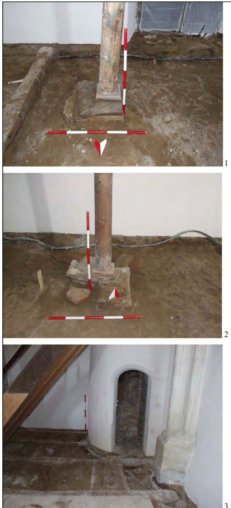
Pl. 16. 1–2. stâlpii din lemn ai emporelor, fixați pe bolovani de piatră. 3. Desfacerea pardoselii în colțul de N–V al navei, cu intrarea la casa scării în spirală ce conduce la etajul de apărare.
