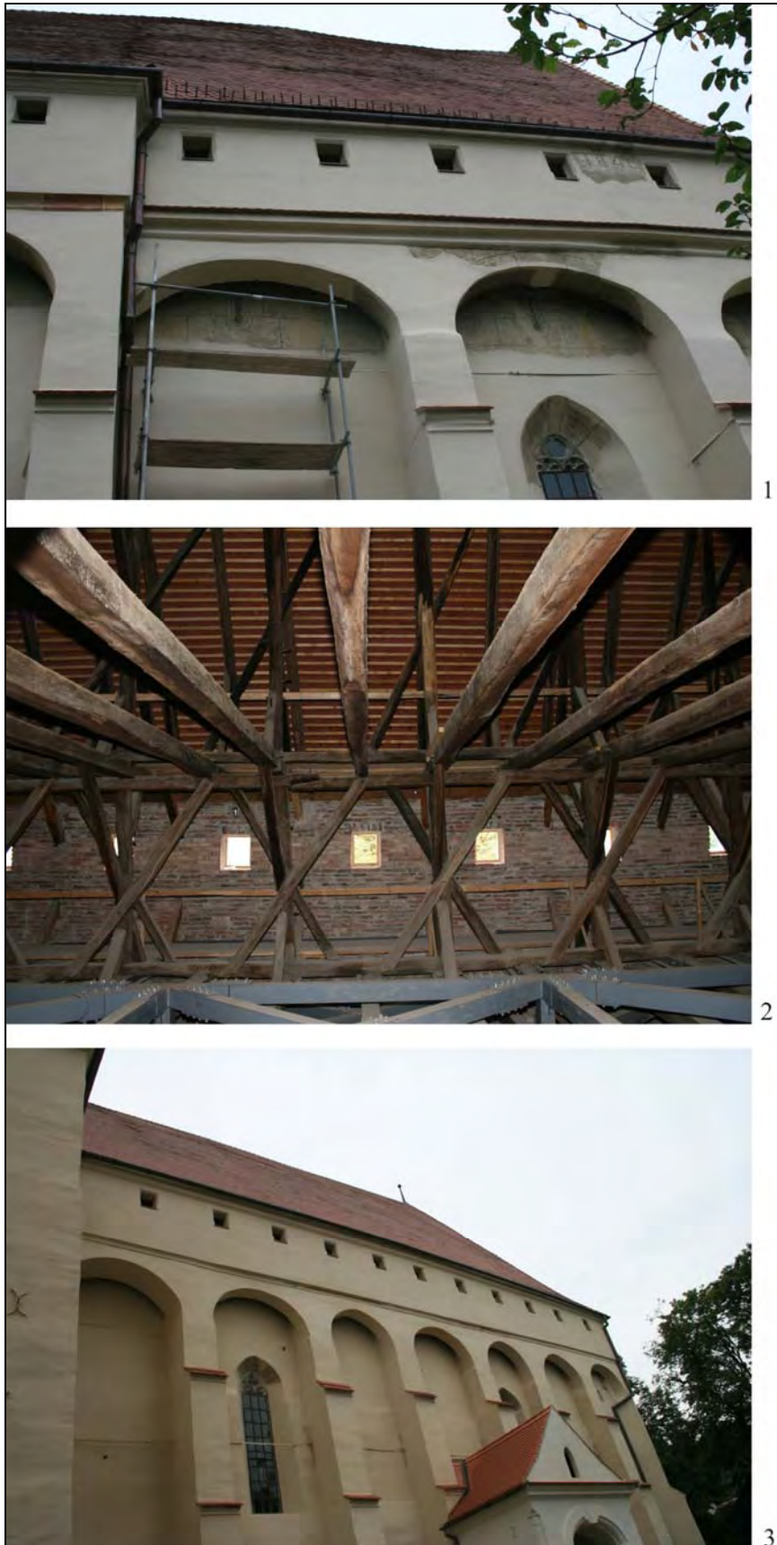
Pl. 3. 1. Detaliu cu etajul de apărare ieșit în consolă, latura de sud, după restaurare. 2. detaliu cu ferestrele de tragere ale etajului de apărare, vedere din pod. 3. Etajul de apărare, latura de sud.
